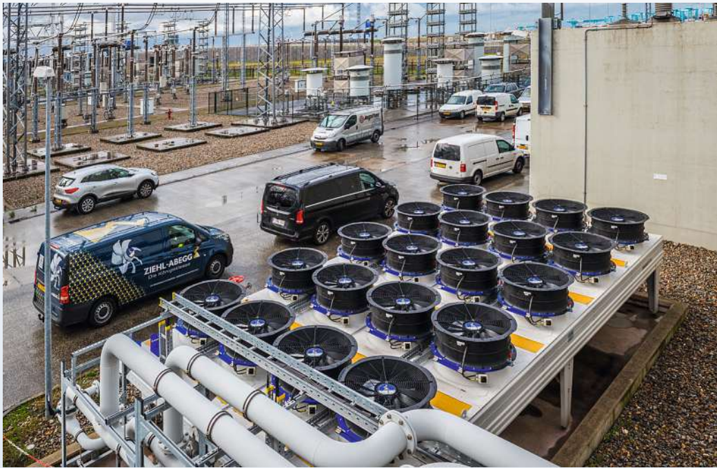
Für die Firma BritNed in Maasvlakte (NL) ersetzte ZIEHL-ABEGG die Ventilatoren, welche für die Kühlung der Stromrichterstation verantwortlich sind. BritNed ist der Betreiber der Hochspannungsgleichstromleitungen, welche Großbritannien und die Niederlande über Unterwasserstarkstromleitungen miteinander verbinden. Die neuen Ventilatoren helfen BritNed, den Stromverbrauch zu senken und die CO 2 -Bilanz zu verbessern.
