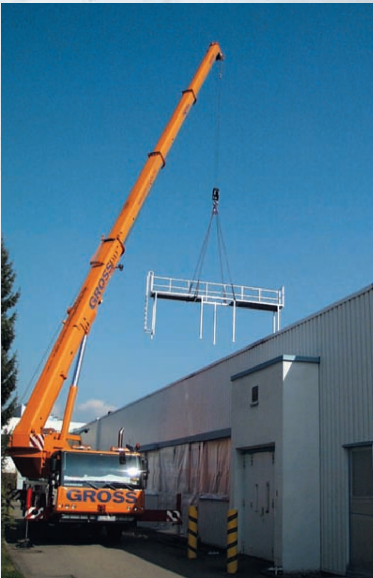
The new ventilation system was lifted to the roof by a crane Die neue Lüftungsanlage wurde mit Hilfe eines Krans auf das Dach verfrachtet
